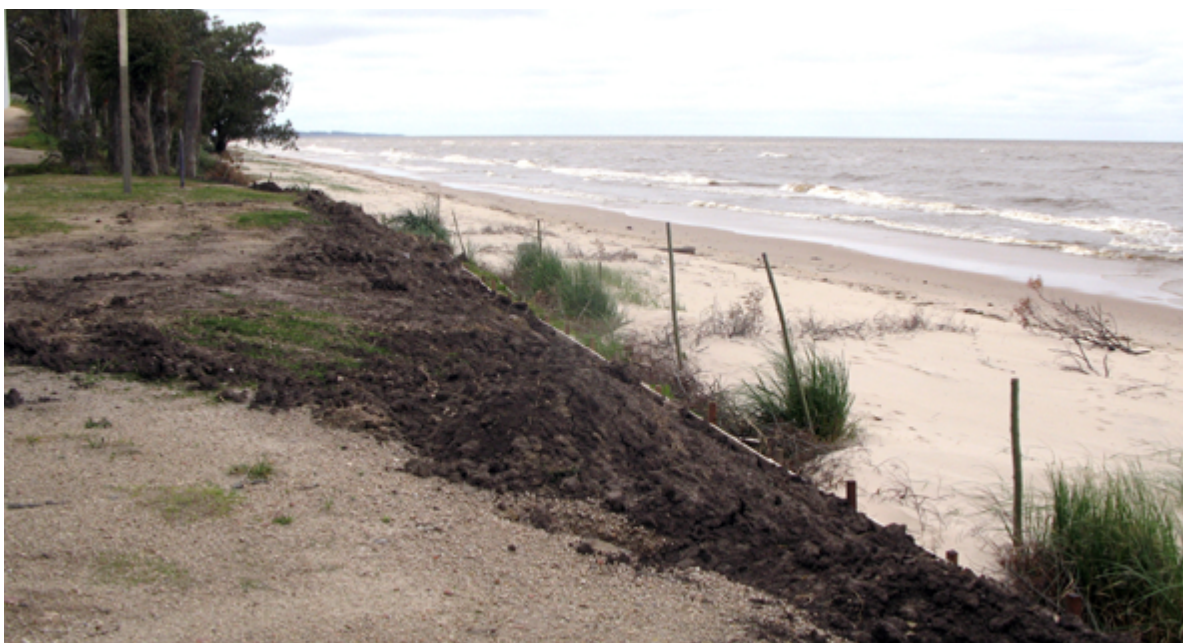
Foto: Obras de reperfilado de barrancas. Amortiguación de pluviales. Archivo del proyecto.
