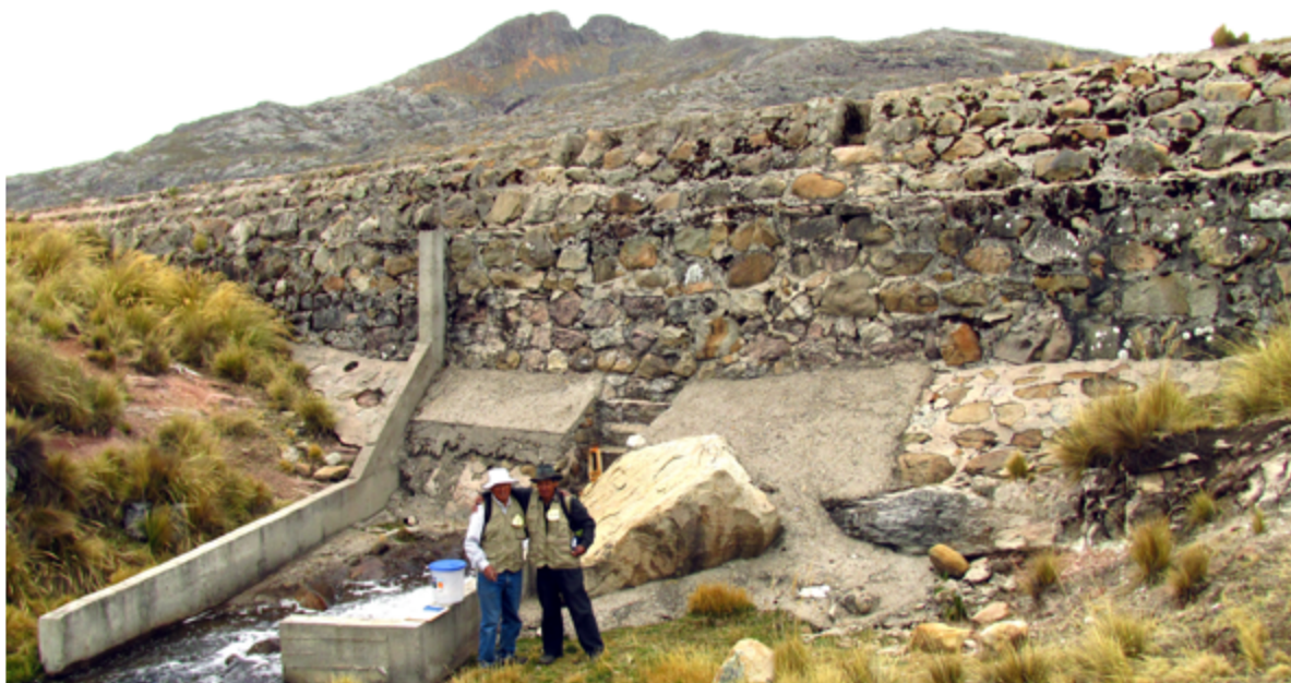
Foto: Mejora de la infraestructura en Canchayllo. Archivo del proyecto.
